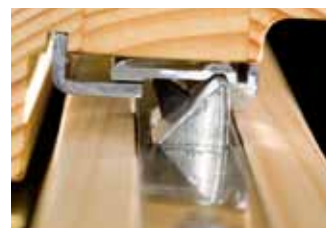
Плавный вход фалевой защелки в ответную планку
